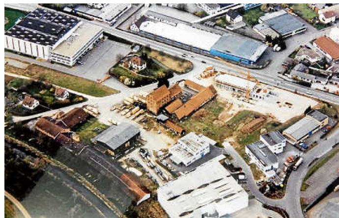
Die Gebäude der ehemaligen Wasenmühle in der Bildmitte Foto: Museumsarchiv
