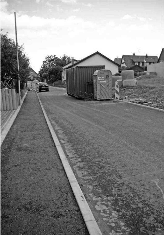
Die der Ausbau der Widerscheinstraße und der Wolfsgasse mit Erschließung eines kleinen Baugebiets wird fertiggestellt.
