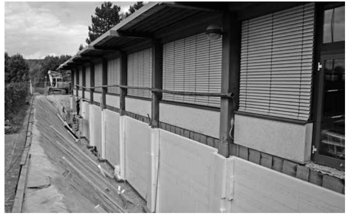
Auch an der Wittumhalle gehen die Sanierungsarbeiten an der in die Jahre gekommene Sporthalle los. Zunächst wird an der Westseite die Außenwand abgedichtet.
