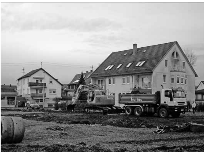
Die Kreisbaugesellschaft beginnt in der Wiesenstraße mit dem Bau eines Mehrfamilienhauses. Dort wird die Gemeinde neben mehreren Sozialwohnungen auch eine weitere Kindertagesstätte einrichten.
