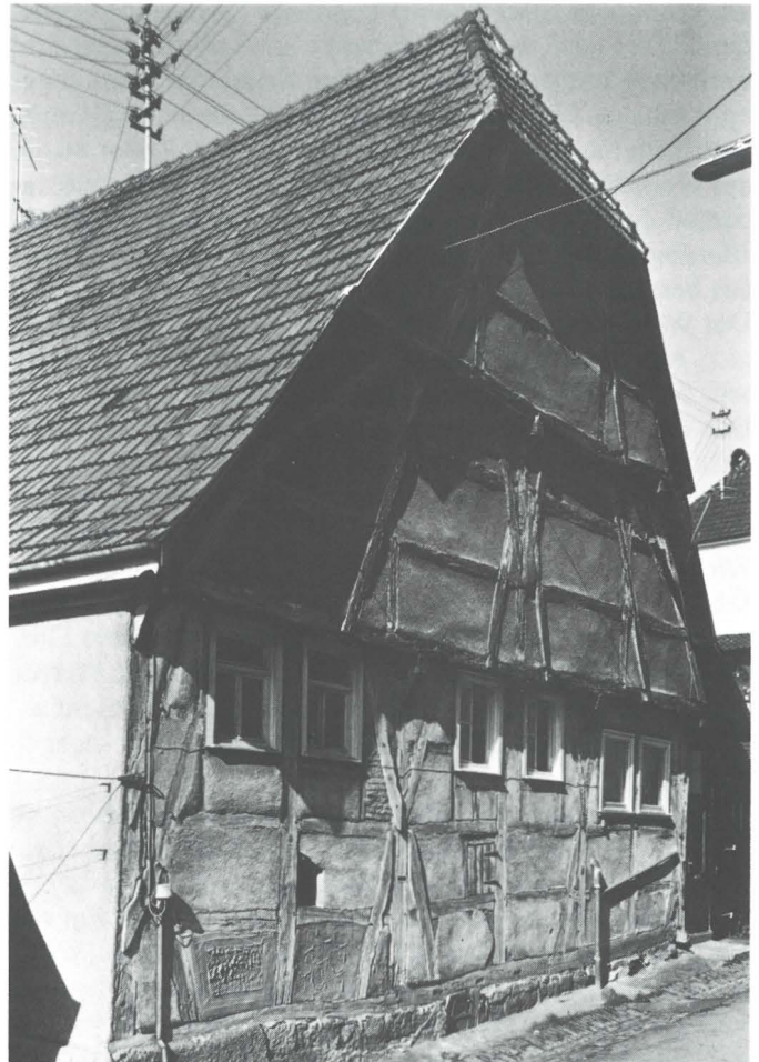
Die ehemalige Widumscheuer in der Kirchgasse gegenüber dem Pfarrhaus. Sie ist, aus dem frühen 16. Jahrhundert stammend, wohl eines der ältesten Häuser Urbachs. Bemerkenswert ist das „alemannische“ Fachwerk. Die überkreuzten Kopf- und Fußbänder nennt man „Wilder Mann“. (Siehe auch Bilder Seite 42.)
