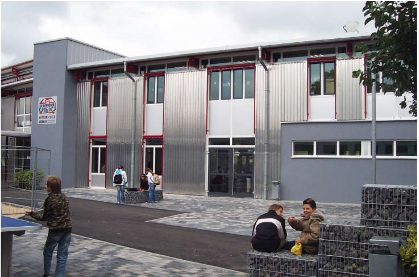
Eine der wichtigsten Investitionen in den vergangenen Jahren war der Anbau an der Wittumschule, der zum Betrieb der Ganztageschule erforderlich wurde.
