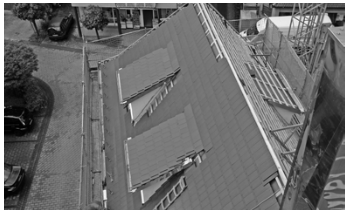
Das Rathaus in der Konrad-Hornsusch-Straße wird energetisch saniert. Der Dachstuhl wird gedämmt und neu gedeckt, die Dachrinnen und Kupferdächer der Türme erneuert.
