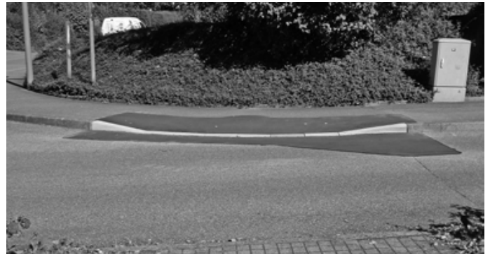
Im Rahmen einer Agenda-Aktion „Rollstuhlgerechtes Urbach“ werden im Ort an mehreren Straßenübergängen die Randsteine abgesenkt, um es den Gehandicapten einfacher zu machen, sich im Ort zu bewegen.
