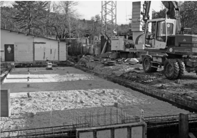
Die Arbeiten für den Neubau des Sanitärtraktes am Urbacher Freibad beginnen. Bis zum Beginn der Badesaison 2011 sollen die neuen Umkleiden, Duschen und der Kassenbereich fertig sein.
