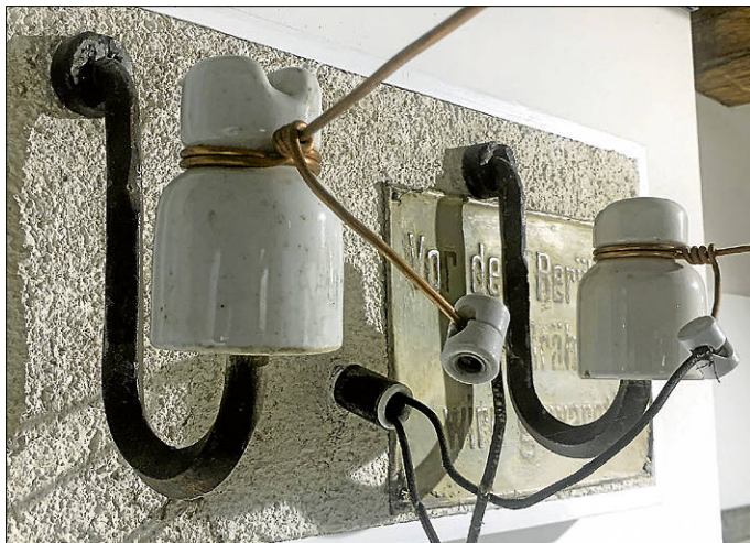
Zuleitung des ehemaligen Hauses Kirchplatz 5
