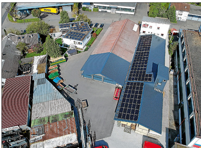
Das Firmengebäude im Industriegebiet in der Robert-Mayer-Straße 6
