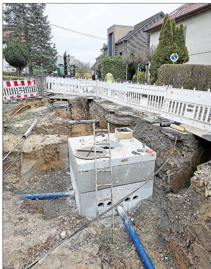
Neuer Hydrantenschacht und neue Rohre im Finkenweg.
