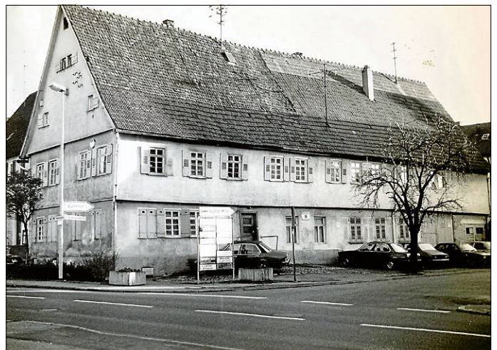
Die Gebäude der ehemaligen Schildwirtschaft „Rose“ an der Ecke Hauptstraße/Bahnhofstraße (heute Konrad-Hornschuch-Straße).
