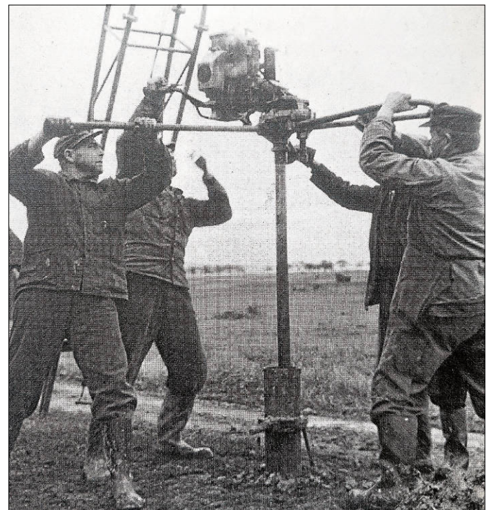
Grundwasserbohrungen auf dem Wasen. Foto von 1949 Foto: Museumsarchiv Urbach
