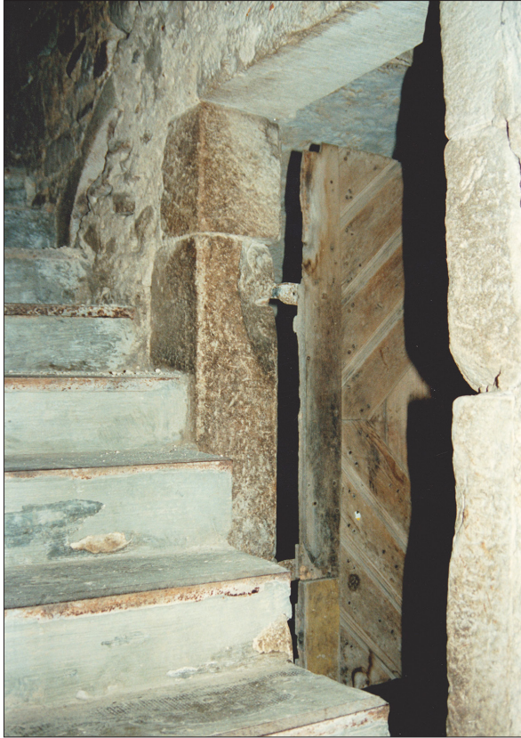
Kellerabgang im Langbau des Urbacher Schlosses. Der Segmentbogen lässt den früheren nach Westen orientierten Kellerzugang erkennen. (W. W. 1989) MaW.
