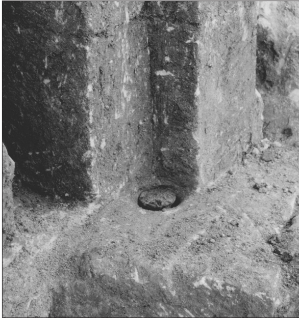
Detailaufnahme des Torbogenansatzes mit einer eisernen Scheibe, auf der eine Türe gedreht wurde. GA Urbach/Museum am Widumhof SaHo.
