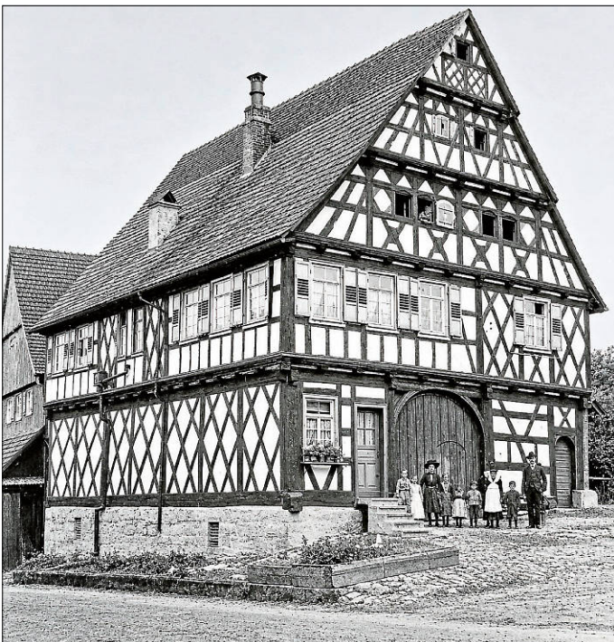
Historische Aufnahme des Gebäudes Mühlstraße 11, die etwa um 1900 aufgenommen wurde Foto: Museumsarchiv
