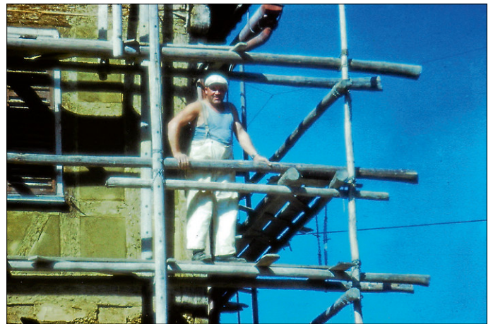
Gotthilf Rebmann auf dem Gerüst, das damals noch aus zusammengebundenen Holzstangen bestand
