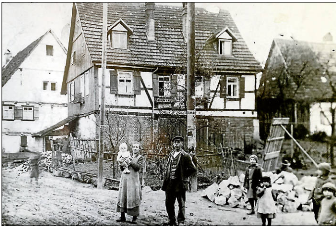
Ansicht aus der Haubersbronner Straße
