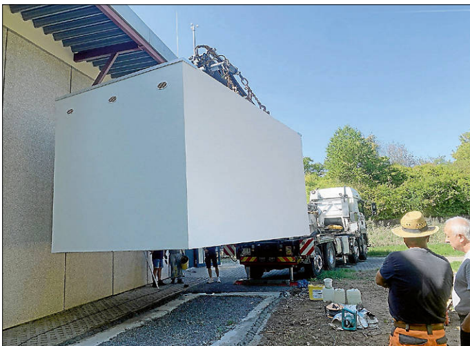
In der vergangenen Woche wurde die Fertiggarage bei der Wittumhalle von der Herstellerfirma geliefert und aufgestellt
