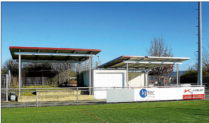
Die neue Überdachung am Kunstrasenplatz im Wittum-Sportzentrum bietet Schutz vor Regen und Sonne
