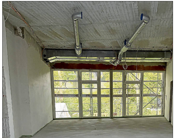
Eine aufwendige Lüftungstechnik sorgt später für ein gutes Raumklima im Gebäude
