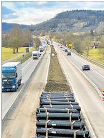
B 29-Baustelle seit Montag erweitert bis zum Sünchen-Tunnel Foto: Gemeinde Urbach
