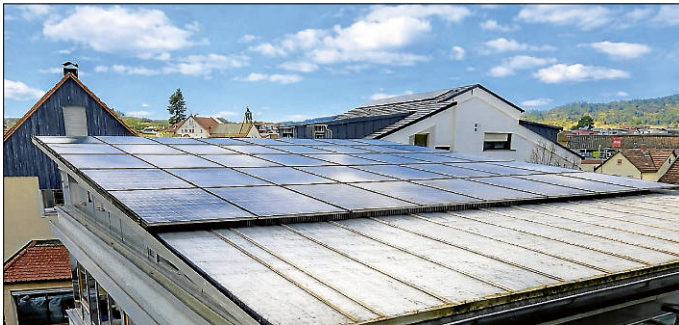
Bild PV-Anlage Rathaus
