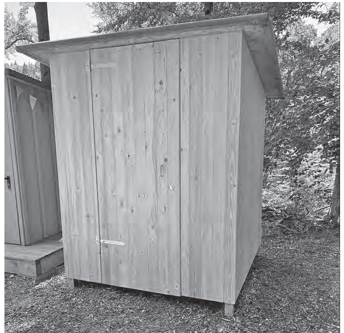
Der fertige Anbau steht.
