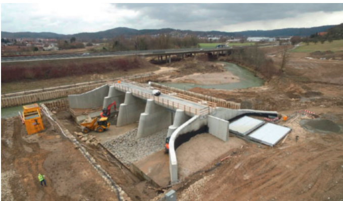
Die größte Baustelle in Urbach präsentiert sich aus der Luft gesehen eindrucksvoll. Das Sperrbauwerk des Hochwasserrückhaltebeckens IV an der Rems zwischen Plüderhausen und Urbach ist nahezu fertig.
