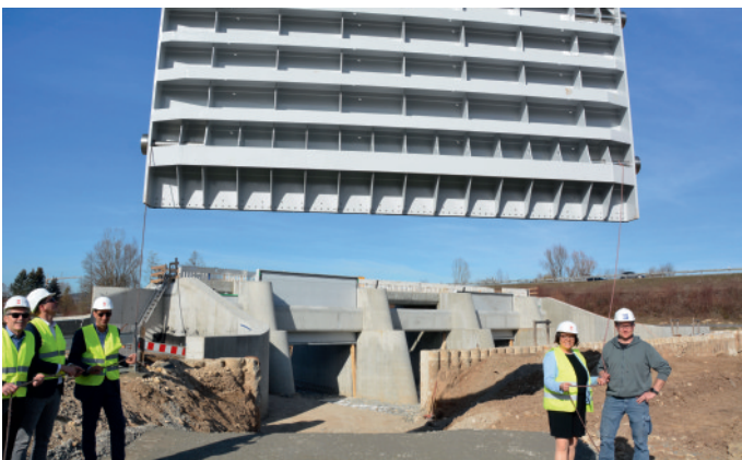
Noch im selben Monat feiern die (Ober)Bürgermeister von Schorn-dorf, Urbach und Plüderhausen die so genannte „Hochzeit“ – die schweren „Schütze“ aus Stahl, wie die Fallklappen des Wehres im Fachjargon heißen, werden in einer spektakulären Aktion in das Sperrbauwerk eingebaut.
