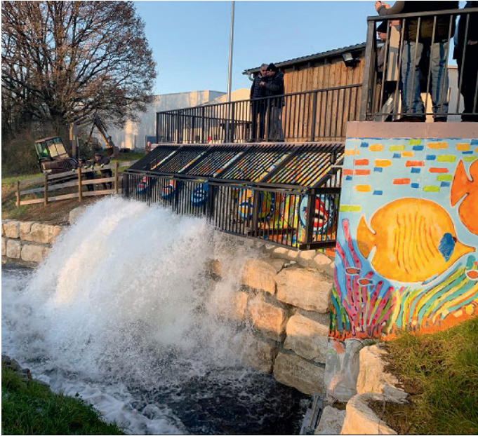
Bei der Urbach-Mündung an der Rems wird das neue Hochwasserpumpwerk probeweise erfolgreich in Betrieb genommen. Die gewaltigen Pumpen befördern bei Starkregen das Wasser aus dem Trennsystem des Industrie- bzw. Gewerbegebiets in die Rems.
