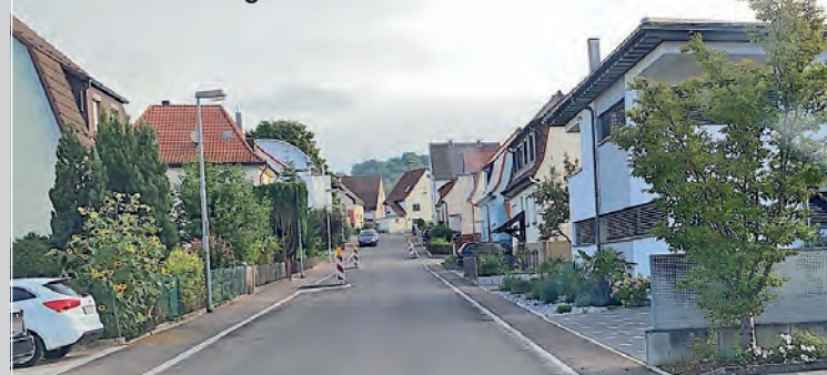
Die Kanalerneuerung in der Widerscheinstraße sowie der Kanalanschluss der Atriumschule erfolgte durch die Urbacher Firma Wilhelm Weidler GmbH & Co KG. In einer Bauzeit von 3 Monaten war es wichtig, durch den Baumaschinenlärm den Schulbetrieb so wenig wie möglich zu stören.
