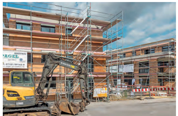
Außenansicht der Baustelle des Kooperationsprojekts der Kreisbaugesellschaft Waiblingen und dem Bau- und Wohnungsverein Stuttgart
