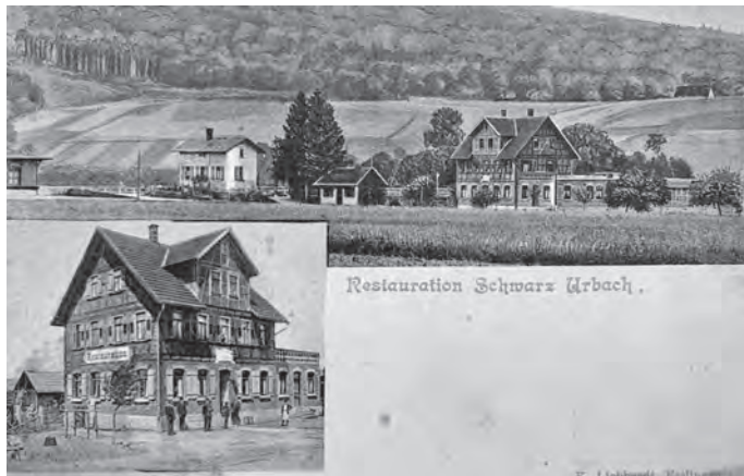
Die Bahnhofs-Wirtschaft „Krone“ mit „Bahnwartshaus“ und „Personenwartelokal“ Foto: Museumsarchiv
